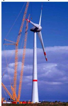
Трехлопастная ВЭУ, модель Enercon E-126, номинальной мощностью 7 МВт, Enercon GmbH
