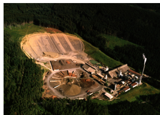
Керамзитовый завод компании Liapor GmbH г. Тюнинген
