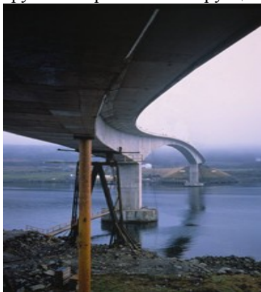
Рис. 8 Мост из керамзитобетона Stovset в Норвегии
