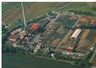
Керамзитовый завод компании Liapor GmbH г. Пауцфельд
