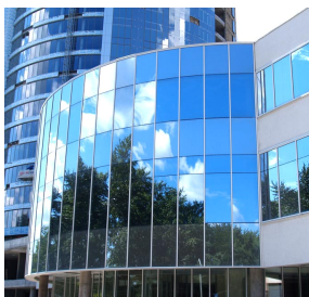
Рис.6. Внешнее остекление зданий многофункциональным стеклом.
