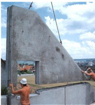
Рис. 7 Строительство индивидуальных жилых домов из керамзитобетонных панелей в Чехии по технологии компании Lias Vintřov LSM
