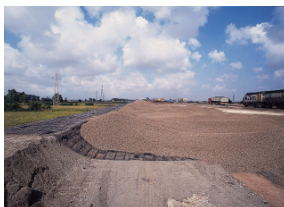
Рис. 10 Строительство автомобильных дорог в Италии с использованием керамзита итальянской компании Laterlite
