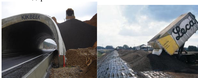
Рис. 9. Строительство автомобильных дорог в Италии с использованием керамзита итальянской компании Laterlite
