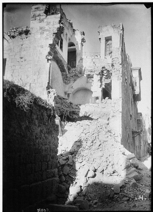
Рис. 2. Последствия землетрясения 1927 года
