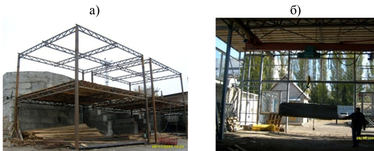
Рисунок 1 – Снимки двухэтажных модулей при возведении складского строения (а) и блоков покрытия промышленного здания с подвесным краном грузоподъемностью 3,2 т во время его испытаний (б)
