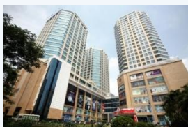
Рисунок 1 – Высотные здания с применением бареттных фундаментов во Вьетнаме
