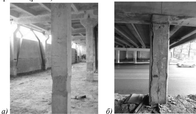
Рисунок 2 – Трещины в теле бетона: а – поперечные трещины; б – продольные трещины
