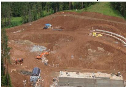
а) устройство подъездных дорог и грунтового основания посадочной зоны
