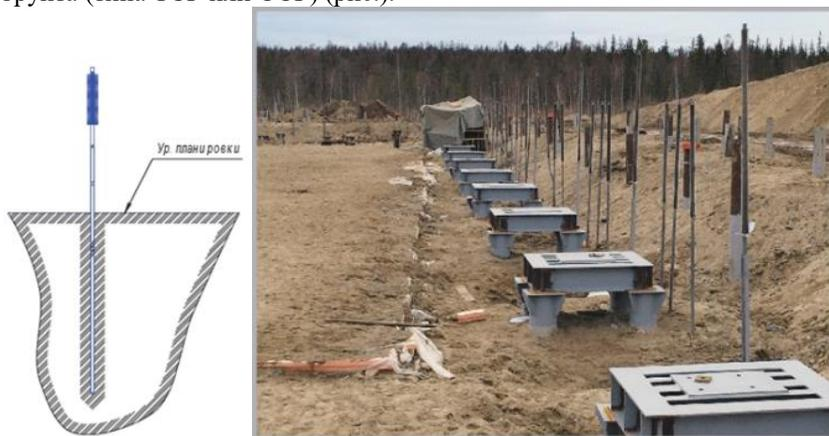
Рисунок 1 – Общий вид термостабилизатора грунта типа ТСГ
