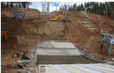
г) уход за бетоном и подготовка грунтового профиля на следующей захватке / ярусе
