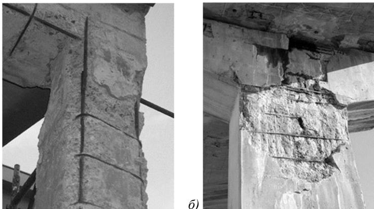
Рисунок 4 – Ослабление сечения элемента по бетону: а - уменьшение высоты/ширины сечения двустороннее; б – то же одностороннее
