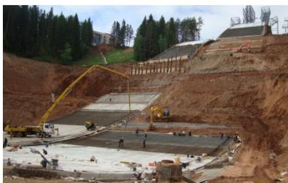
в) бетонирование конструкции искусственного основания посадочной зоны
