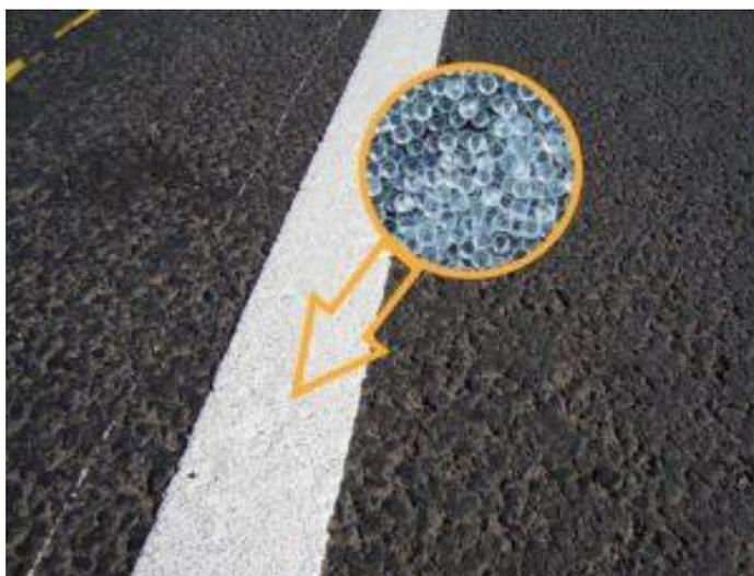
Рисунок 1 – Дорожная разметка с микростеклошариками
