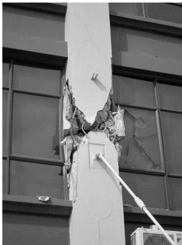
Рисунок 3 – Выпучивание сжатой жесткости», обеспечивает местную устойчивость продольных стержней арматуры колонн.
