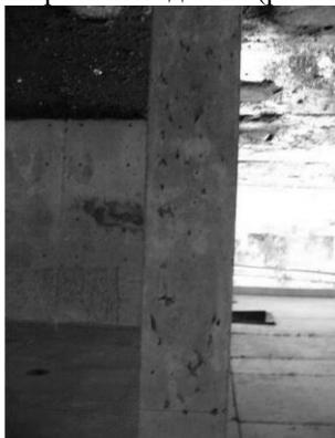
Рисунок 1 – Отклонение оси колонны происходит чаще всего при возведениях конструкций перекрытий/покрытий (ригелей, фермы и плиты) непроектных размеров.
