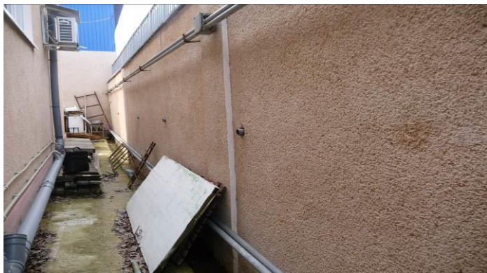
Рисунок 6 - Подпорная стена в нижней части склона
