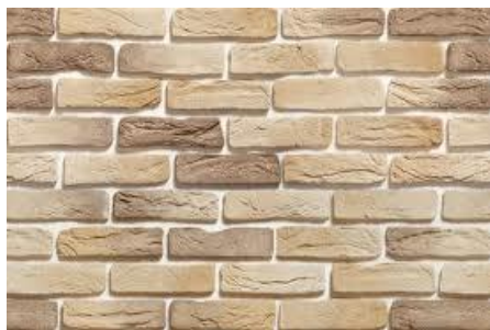
Рисунок 2 - Облицовка декоративным кирпичом
