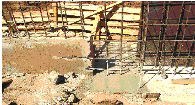
Рисунок 4 - Устройство моноклитной подпорной стены в нижней зоне склона. Омоноклитование участков между плитами
