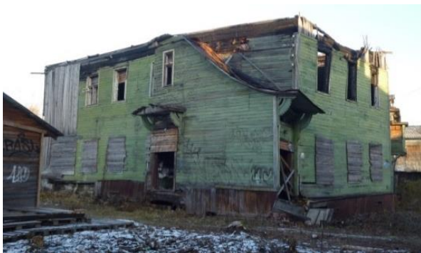
Рисунок 1 – Текущее состояние объекта «Усадьба М.З. Ишмемятова: Флигель»
