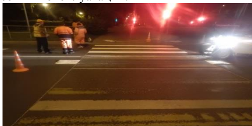
Рисунок 7 - Истирание линий дорожной разметки, выполненной термопластиками. В полосах постоянного наезда колес автотранспорта износ по площади 100%
