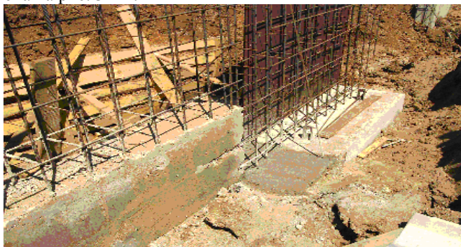
Рисунок 3 - Устройство сборно-моноклитной подпорной стены в нижней зоне склона. Монтаж горизонтальных плит с вертикальными арматурными выпусками
