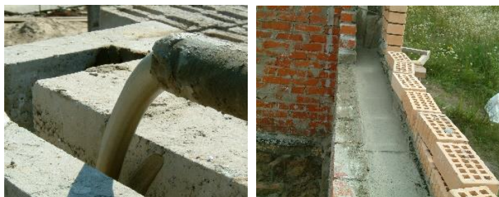
Рисунок 3 - Возведение стены из колодезной кладки с применением неавтоклавного пеногазобетона: а – заливка смеси в колодец стены, б – конструкция колодезной кладки после заливки пеногазобетонной смеси
