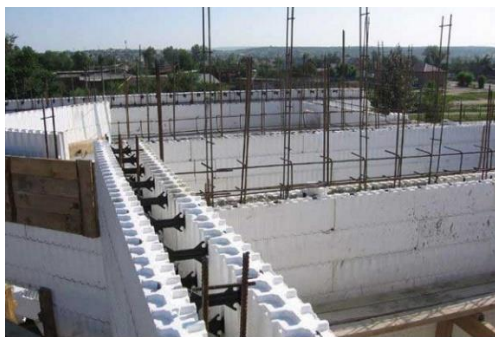
Рисунок 2 - Возведение стен здания из монолитного железобетона.
