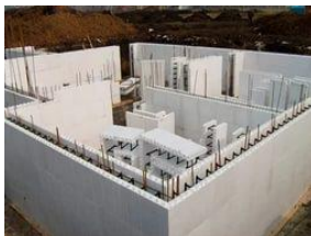
Рисунок 1 – Съемная (а); несъемная (б) опалубки; в) виды установки съемной опалубки; г) устройство армирующего пояса из пеноблоков.
