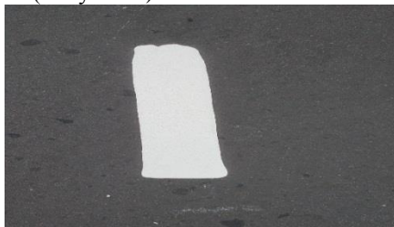
Рисунок 3 - Дефекты геометрии линий дорожной разметки
