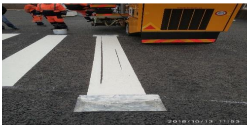
Рисунок 9 - Расслоение термопластика в экструдере машины разметочной машины
