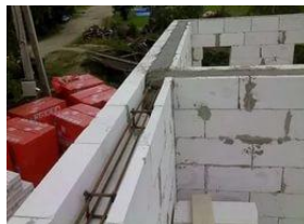
Рисунок 1 – Съемная (а); несъемная (б) опалубки; в) виды установки съемной опалубки; г) устройство армирующего пояса из пеноблоков.
