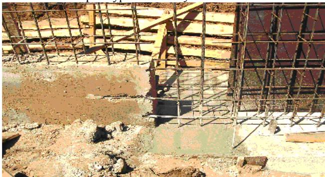
Рисунок 4 - Устройство моноклитной подпорной стены в нижней зоне склона. Омоноклитивание участков между плитами
