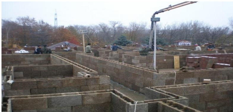
Рисунок 4 – Опалубка (несъемная) «DURISOL»
