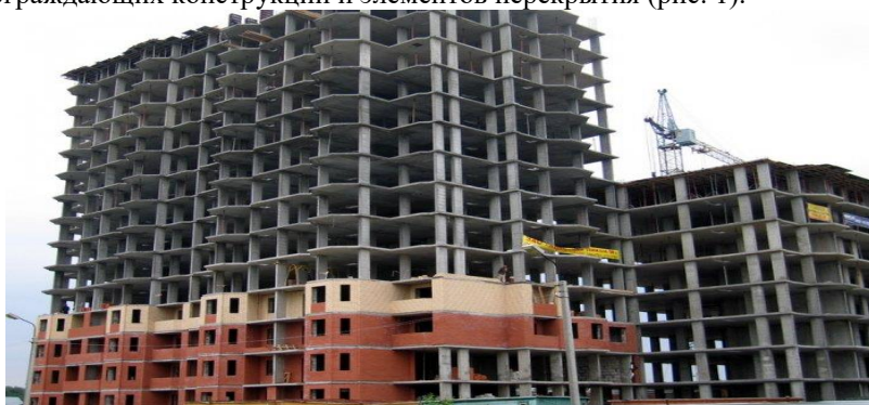
Рисунок 1 – Возведение здания из монолитного железобетона
