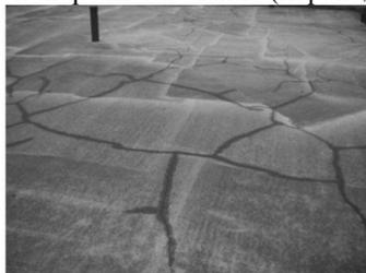
Рисунок 1 – Образовавшиеся трещины на поверхности бетонного пола в первые 4 часа поле заливки [5]
