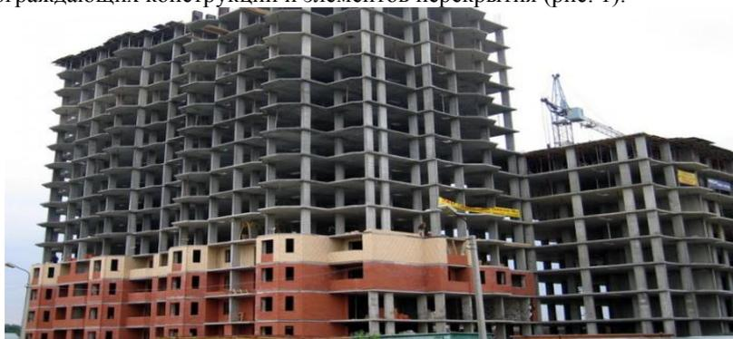
Рисунок 1 – Возведение здания из монолитного железобетона
