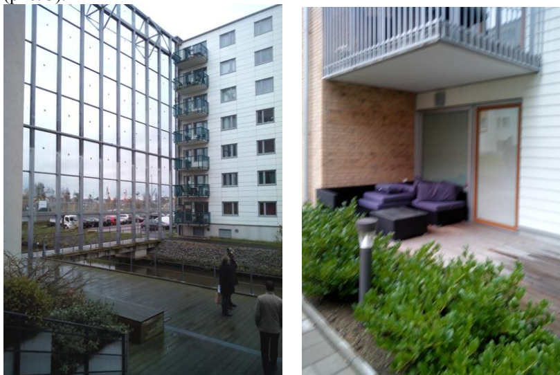
Рисунок 3 – Стеклянный экран, соединяющий торцы здания (слева) и терраса для квартиры на первом этаже (справа) Фото М.В. Перьковой
